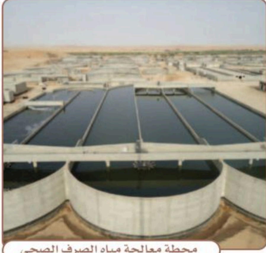
محطة معالجة مياه الصرف الصحي
