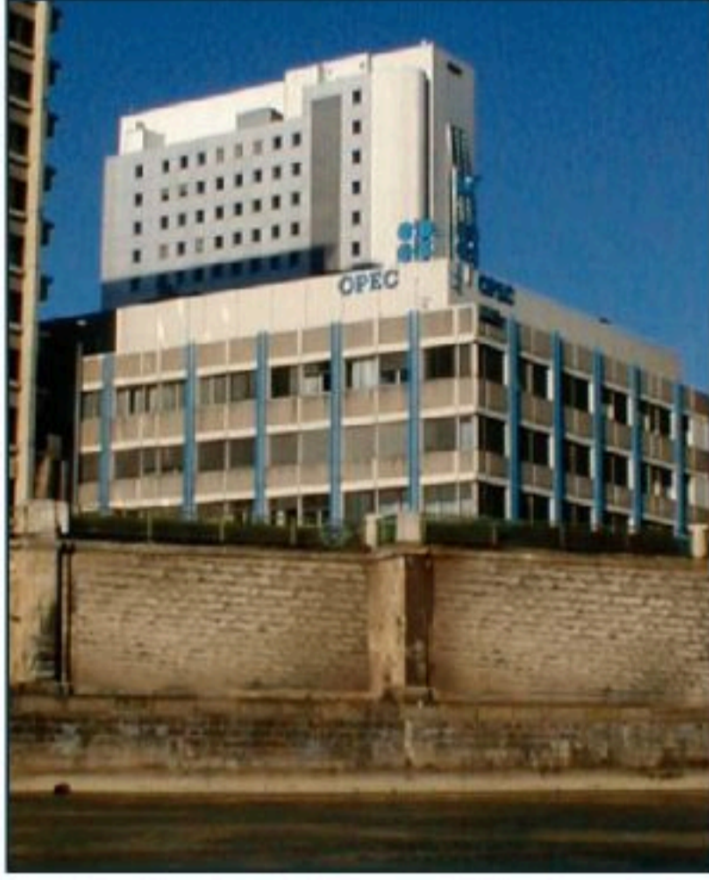
▲ مبنى منظمة أوبك في فيينا
